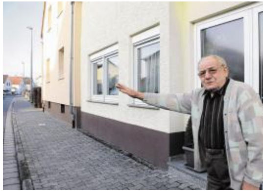
An Helmut Beckers Elternhaus, Hasslocher Straße 28, vor dem er hier steht und das der Raunheimer wie vor 60 Jahren bewohnt, wurde die rückwärtige Fassade abgerissen, als ein US-Flugzeug abstürzte. Das Haus nebenan wurde dem Erdboden gleichgemacht. Foto: Rüdiger Koslowski
